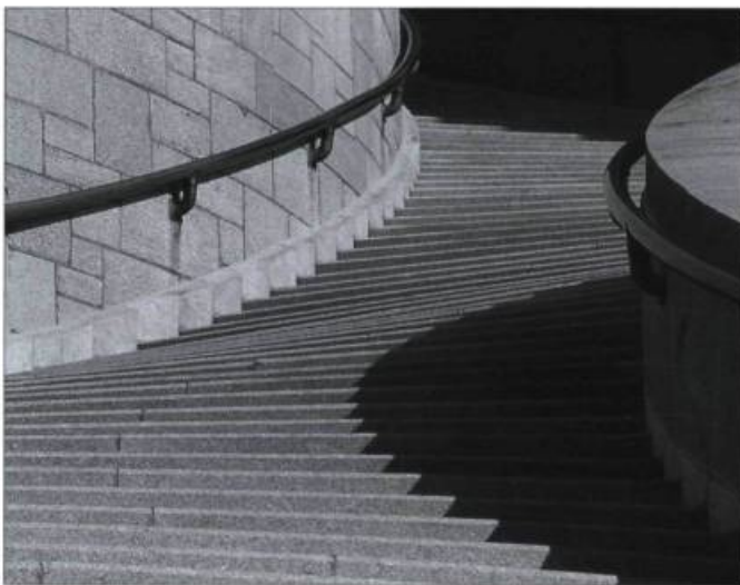
La topographie du site de l'Oratoire Saint-Joseph a imposé dès le début des réflexions et des aménagements pour résoudre les problèmes d'accessibilité.
