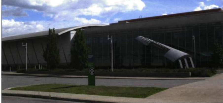
Le troisième temps de l'architecture scolaire moderne, qui formule les enjeux contemporains, est bien représenté par la construction high-tech qu'est l'École des métiers de l'aérospatiale, sise rue Chauveau dans Hochelaga-Maisonneuve. Construit en 1994, ce bâtiment possède une fenestration abondante. En façade, l'œuvre de Liliana Berezowsky.
