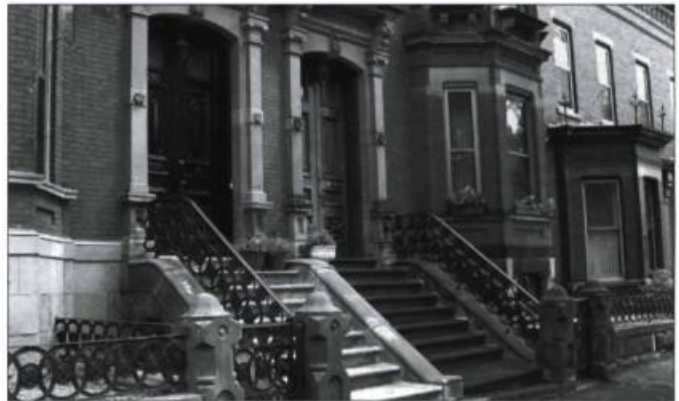
Belles demeures de la rue Germain à Saint John au Nouveau-Brunswick. On en a préservé les entrées et les éléments fonctionnels et décoratifs, qui s'avèrent importants pour définir la valeur patrimoniale de ces maisons.
