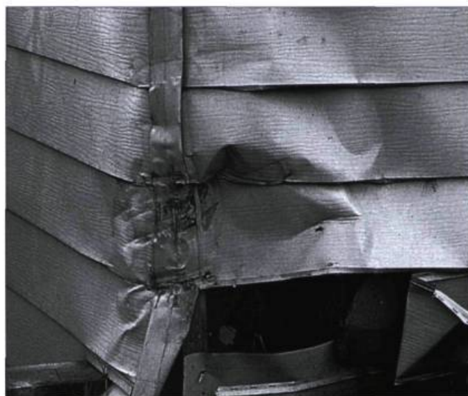
Par temps froid ou sous un impact, les revêtements d'aluminium ou de vinyle peuvent se déformer ou se casser. Le bois s'avère plus durable et résistant que ses concurrents modernes.
