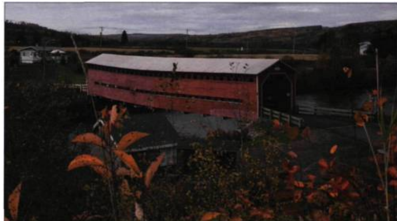
Le pont Heppell, à Causapschal dans le Bas-Saint-Laurent, a fêté ses 100 ans cet été, après avoir frôlé la destruction au printemps 1991, alors que la crue des eaux et une utilisation abusive l'avaient sérieusement endommagé.
