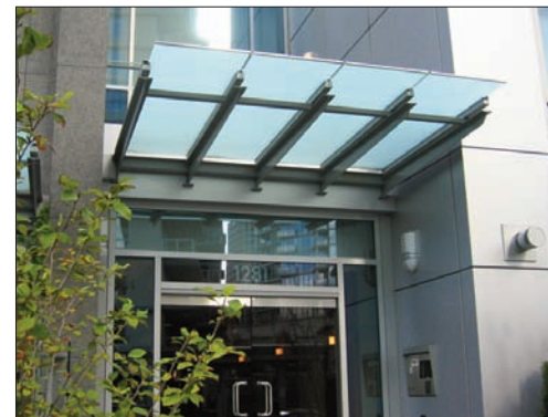
Ossature d'acier et toit de verre armé composent souvent les marquises contemporaines.
