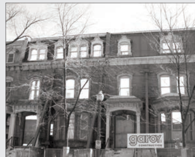
À la fin du XIX e siècle, plusieurs maisons en terrasse de style victorien ont été construites sur la Grande Allée. Le projet d'hôtel à l'angle de la rue D'Artigny n'a conservé que l'apparence des immeubles.
