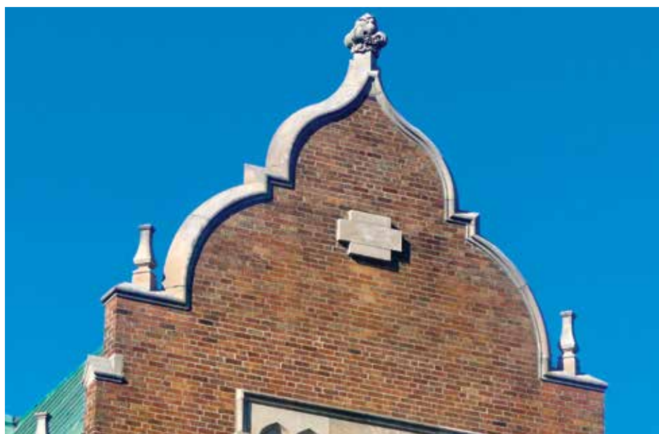
Même une construction néogothique élaborée comme le pavillon principal du campus Loyola de l'Université Concordia comporte plusieurs tables d'attente abandonnées, dont celle qu'on distingue ici sur sa façade.
