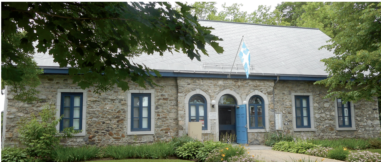
C'est notamment grâce aux efforts du Comité de promotion du patrimoine de Beaumont que le vieux presbytère de l'endroit, incendié en 1979, a été reconstruit et converti en bibliothèque.
