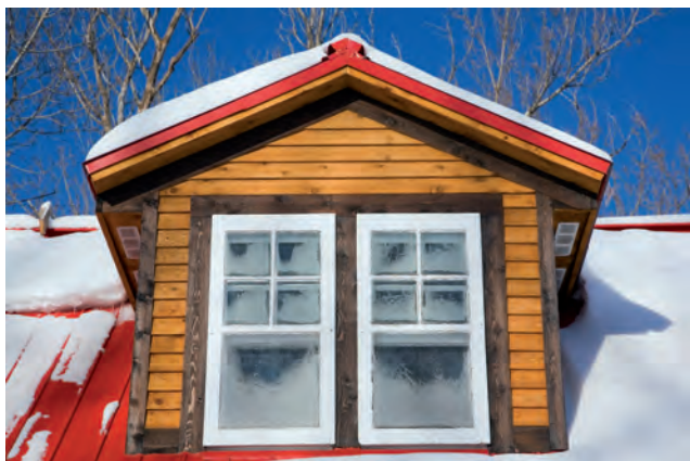
Grâce à la couche d'air qui se trouve entre ses deux vitres, la double fenêtre procure une meilleure isolation que la simple.
