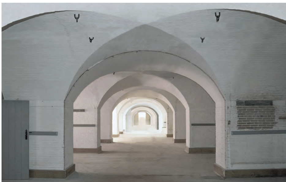
Le décroisement du rez-de-chaussée de la caserne permet d'en apprécier l'étonnante architecture. Source : Ambidex
