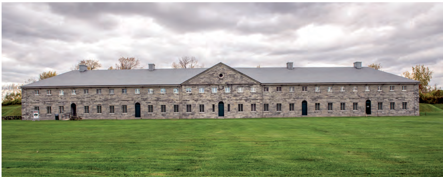
La restauration de la caserne constituait un défi, les assises du bâtiment ayant été affaiblies par le niveau élevé de la nappe phréatique. Source : Parcs Canada
