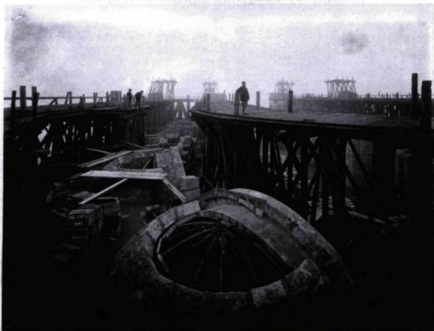
Louis-Émile Durandelle Construction des voûtes des absidioles, vue du côté est prise vers le sud du Sacré-Cœur de Paris : Paul Abadie, Honoré Daumet, Charles Laisné, Henri Rauline, Lucien Magne et Jean Hulot, architectes Épreuve argentique à l'albumine 30 octobre 1884 32,6 x 42,8 cm
