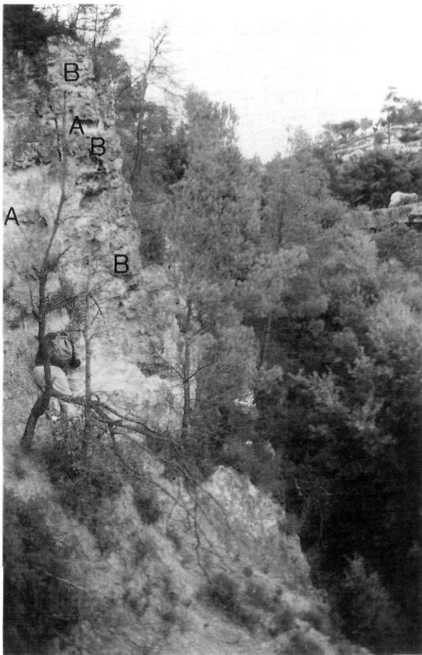
FIGURE 2. Coupe de Saint-Antonin (B-du-R) : ensemble détritique et travertineux supérieur (A : faciès détritique, B : tuf à empreintes), rive droite du Bayon en aval de la cascade. On remarque l'importance de l'entaille historique.
