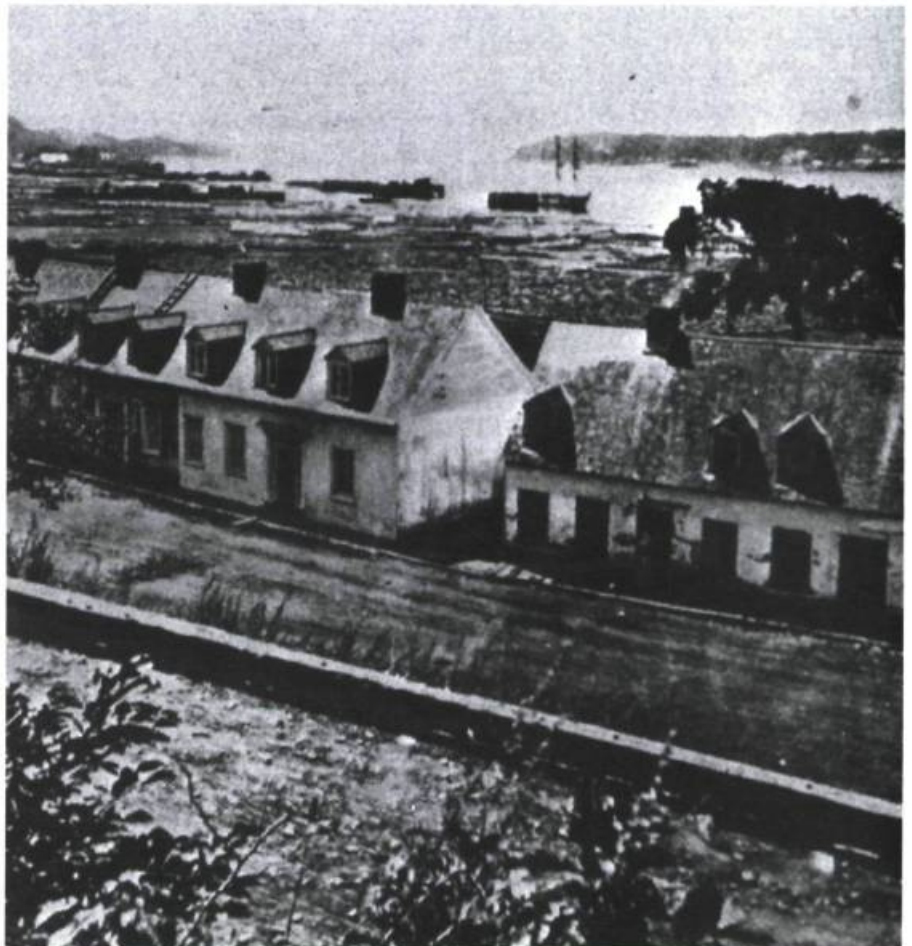
On peut voir sur ces maisons de la rue Champlain à Québec, des échelles dont on peut se servir en cas d'incendie. (Archives nationales du Québec)
