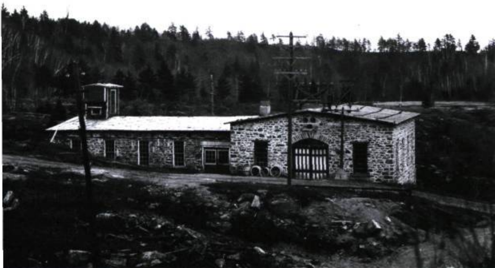
La première centrale hydroélectrique de la Mauricie a vu le jour à Saint-Narcisse, en 1897.
