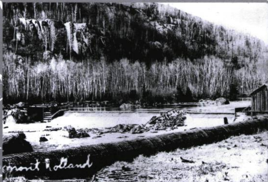
Première digue et tuyaux d'alimentation en eau pour l'usine construite en 1902-1903. (Source : Collection du Parc d'affaires La Rolland)
