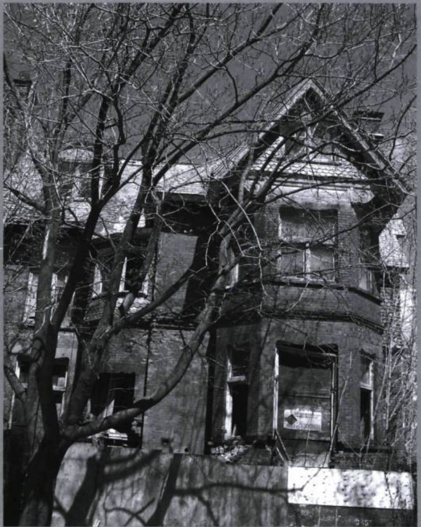
La maison Redpath, 3457, rue du Musée, à Montréal, a été construite pour John Redpath (raffinerie de sucre) en 1886 et est l'une des rares maisons de style Queen Anne encore présentes à Montréal. Sauvée in extremis de la démolition totale cent ans plus tard, grâce à une injonction obtenue par Héritage Montréal et Sauvons Montréal, la maison a été laissée à elle-même depuis... (Photo : R.M. Bégin, 2007)
