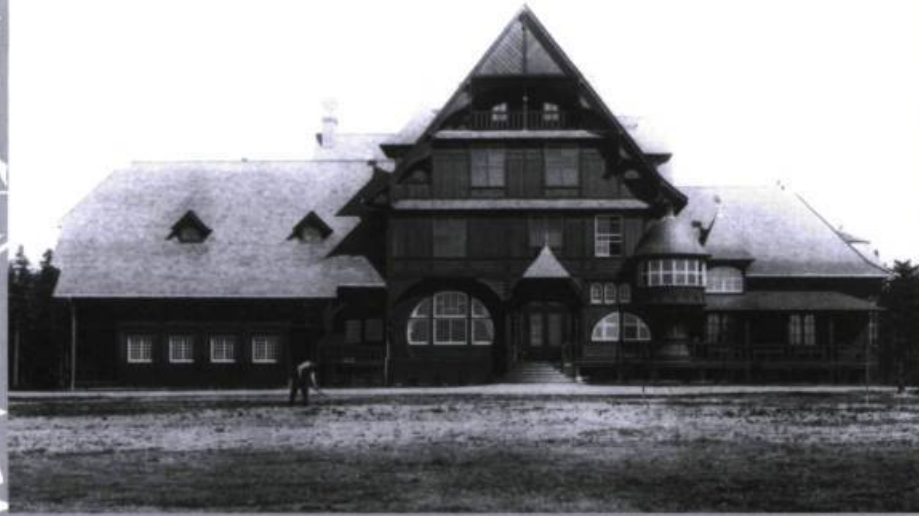
Jardinier devant la Villa. Photographie montrant l'ampleur de cette construction. (Source : Collection privée)
