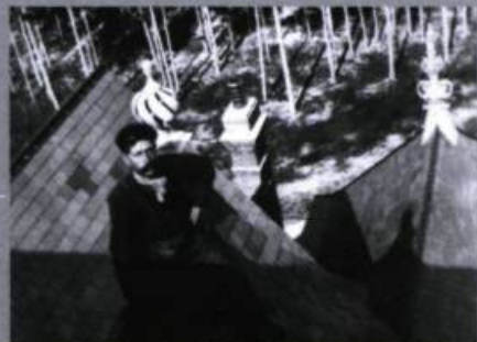
Joseph-Élie Trépanier, plombier-ferblantier, inspectant les ardoises du toit de la villa. À remarquer, le raffinement des cheminées et des têtes de faite. Photo prise vers 1910. (Source : Collection privée)
