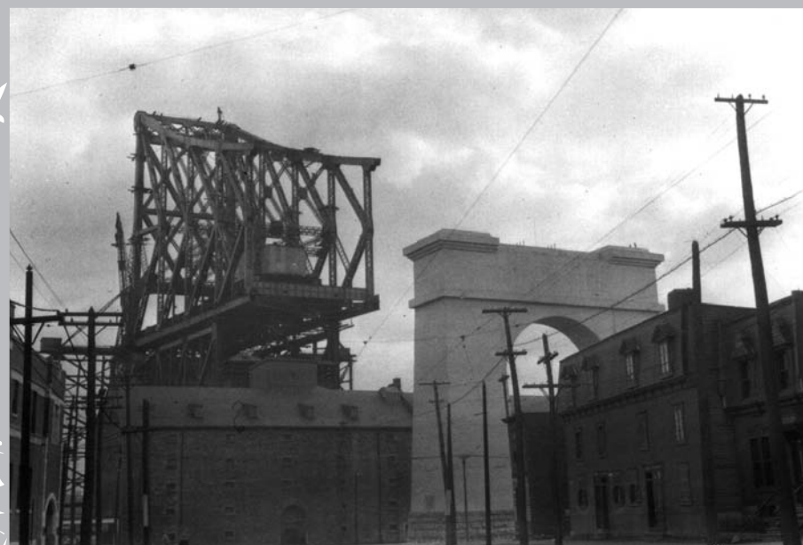
La construction du pont entraîne de nombreuses démolitions dans le quartier Sainte-Marie. (Compagnie Dominion Bridge, Bibliothèque et Archives Canada)
