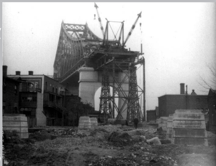
La construction du pont ouvre une brèche dans le tissu urbain.
