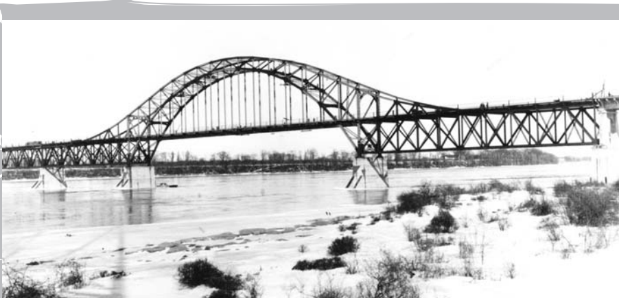
Le 15 mars 1934, vue générale du pont Honoré-Mercier, les travées 11, 12 et 13 terminées.
