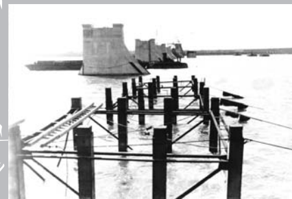
Le 23 octobre 1933, lors de la construction du pont du lac Saint-Louis entre Kahnawake et LaSalle : démolition de la passerelle, pontage enlevé. (Source : Société historique Cavelier-de-LaSalle)
