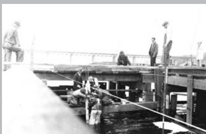
Le 28 mai 1933, au cours de la construction du pont du lac Saint-Louis entre Kahnawake et LaSalle : descente d'un scaphandrier pour l'examen du lit de la rivière; à l'arrière plan, vue du pont Saint-Laurent, propriété du Canadien Pacifique. (Source : Société historique Cavelier-de-LaSalle)
