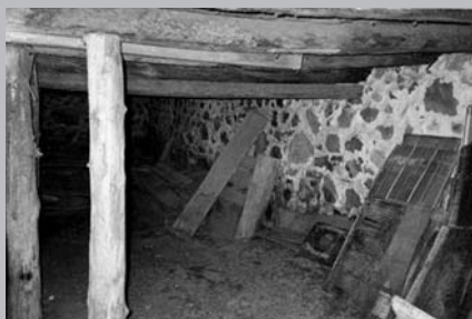
Au sous-sol, les arbres écorcés servent de poutres de soutien. (Source : Collection: Colette Légaré)
