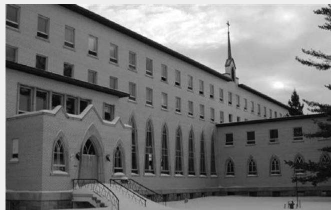
L'édifice désaffecté des Augustines (pas très attrayant, mais qui démontre l'ampleur de ces édifices qui pourraient être réutilisés... dans un esprit de développement durable. (Source : Société d'histoire de Sillery)
