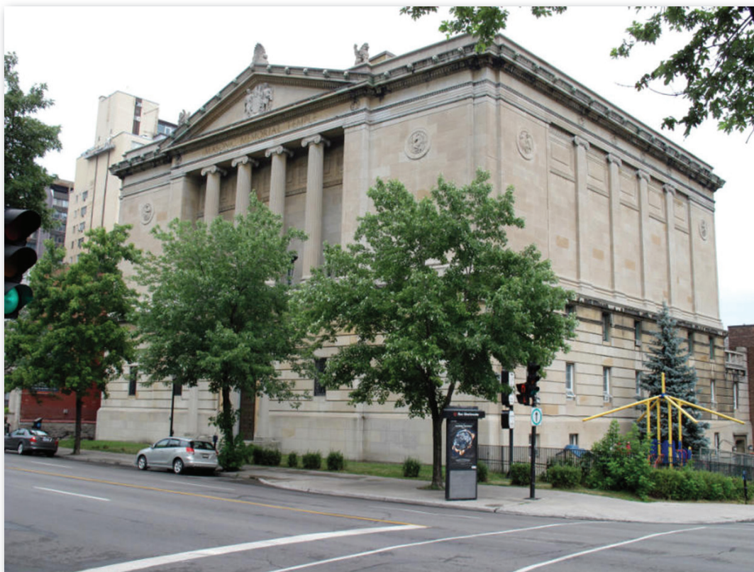
Vue de la façade et du mur ouest du Masonic Memorial Temple en 2012. (Photographe : Marie-Ève Bonenfant pour le ministère de la Culture et des Communications du Québec, tiré du Registre du patrimoine culturel du Québec, consulté le 21 avril 2017)
