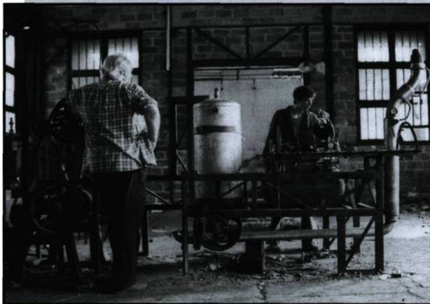
La machine que l'on démonte, comme pour marquer le compte à rebours du temps.
