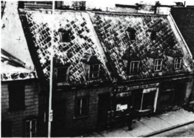
Côte d'Abraham 550 - 564 - 570. Placardée et délabrée
