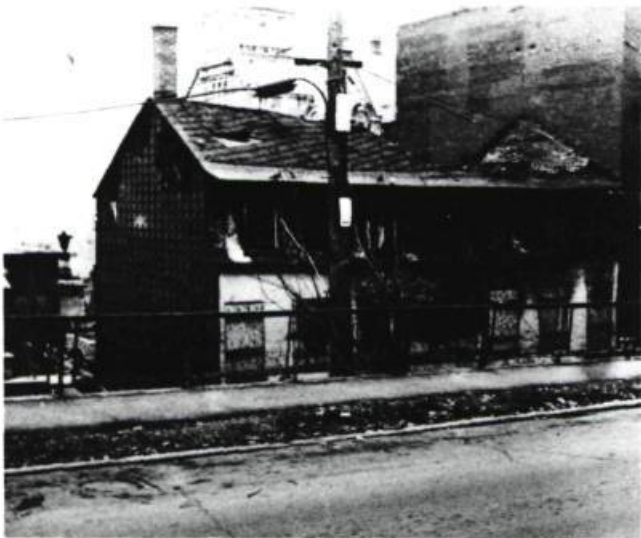
—Entre 388 et 396 Lockwell Incendiée et éventrée. Vestiges abandonnés Depuis plusieurs années et danger permanent pour l'environnement
