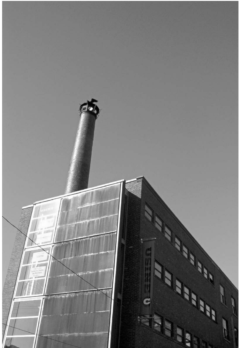
L'Usine C, ancienne usine des confitures Raymond, rue Lalonde. © Usine C.
