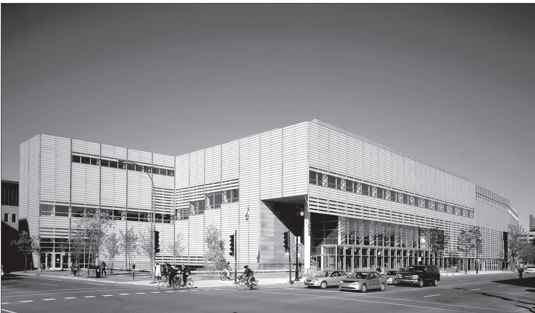
La Grande Bibliothèque vue de l'extérieur
