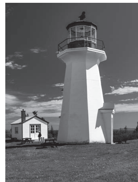
Au cap Gaspé, la maison de phare de bois de 1874 sera remplacée en 1950 par une tour de béton de forme octogonale.
