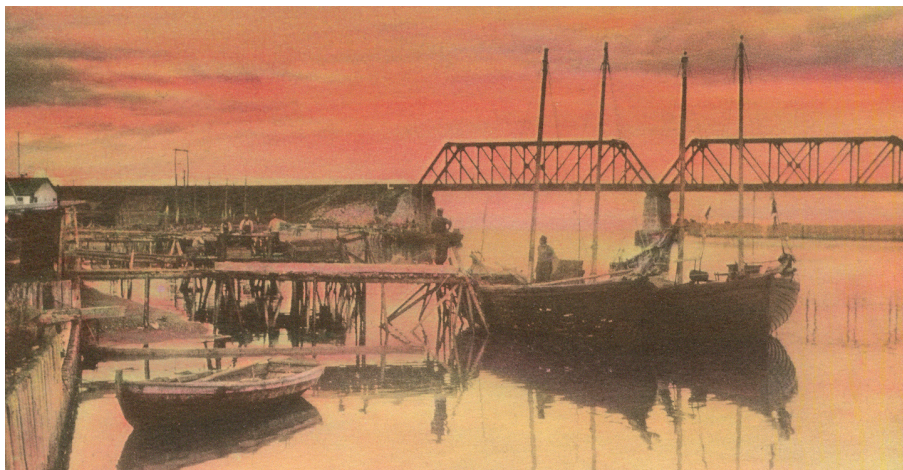
Pont ferroviaire à Barachois, vers 1930.
