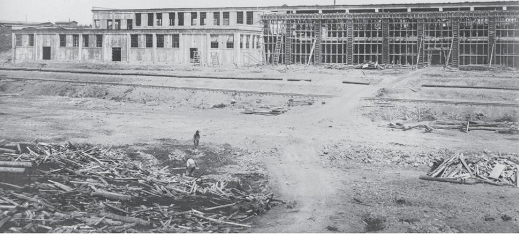
Usine en construction, vers 1913. L'excavation se fait au pic et à la pelle alors que la terre est transportée dans des charriots tirés par des chevaux.
