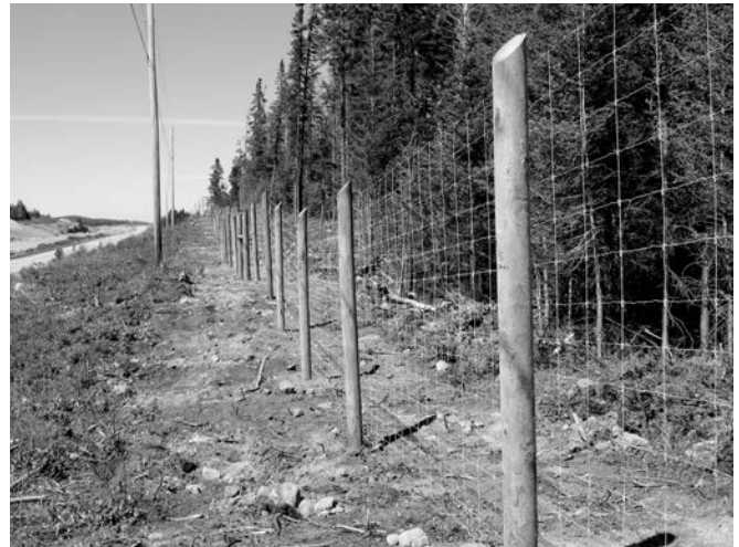
Figure 1. La clôture métallique de 2,4 m constitue une mesure d'atténuation efficace pour contrer les accidents routiers. Idéalement, l'aménagement doit être réalisé dans les secteurs les plus propices au passage des orignaux.
