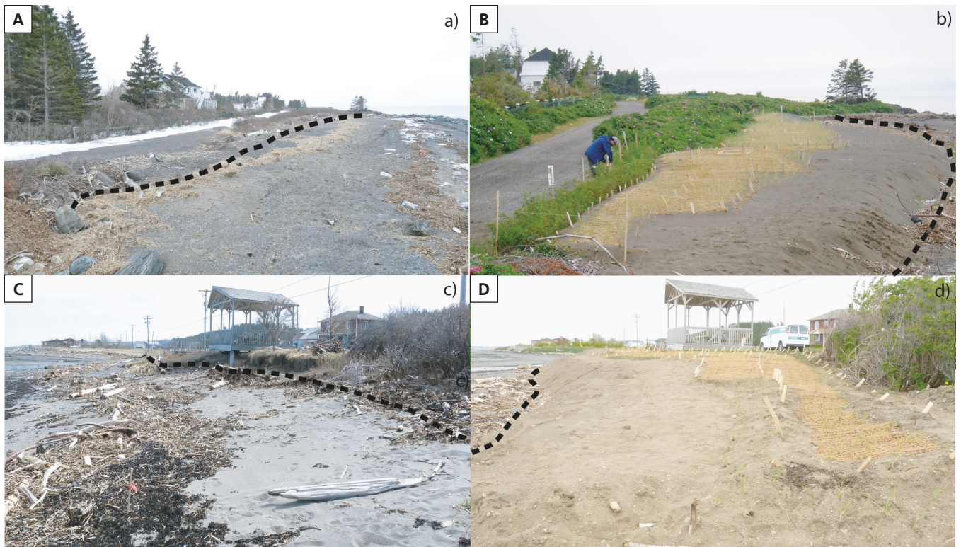
Figure 3. Plage de Rivière-Ouelle avant A) et après B) les travaux de restauration. Plage de Sainte-Flavie avant C) et après D) les travaux de restauration. La ligne de rivage, qui correspond aussi à la fin de la recharge (B et D), est indiquée en pointillé (source: Comité Zip du Sud-de-l'Estuaire).
