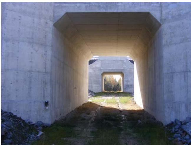
Figure 3. Le passage faunique inférieur (écoduc) de Burwash comprend 2 ponceaux carrés identiques et une ouverture médiane clôturée.
