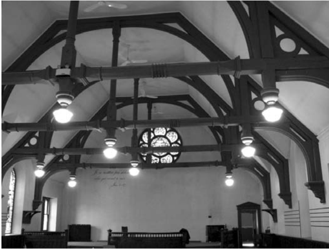
Intérieur de l'église avant les travaux, 2009. Collection MUSO – Musée de société des Deux-Rives.
