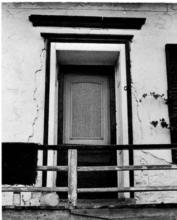
FIGURE 6. Maison Darveau, vue de la porte principale surmontée d'une corniche de pierre taillée. (Photo : Inventaire des Biens culturels )
