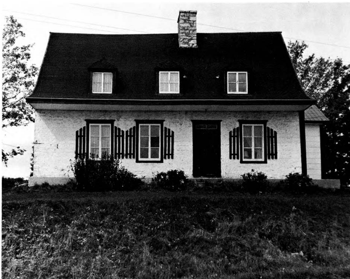
FIGURE 3. Maison Jobin, vue de face. Construite en 1768-69. (Photo : Inventaire des Biens culturels)
