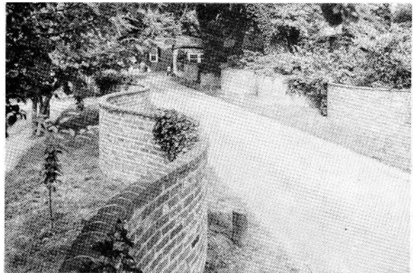
FIGURE 13. Détail d'un mur de forme serpentine.
