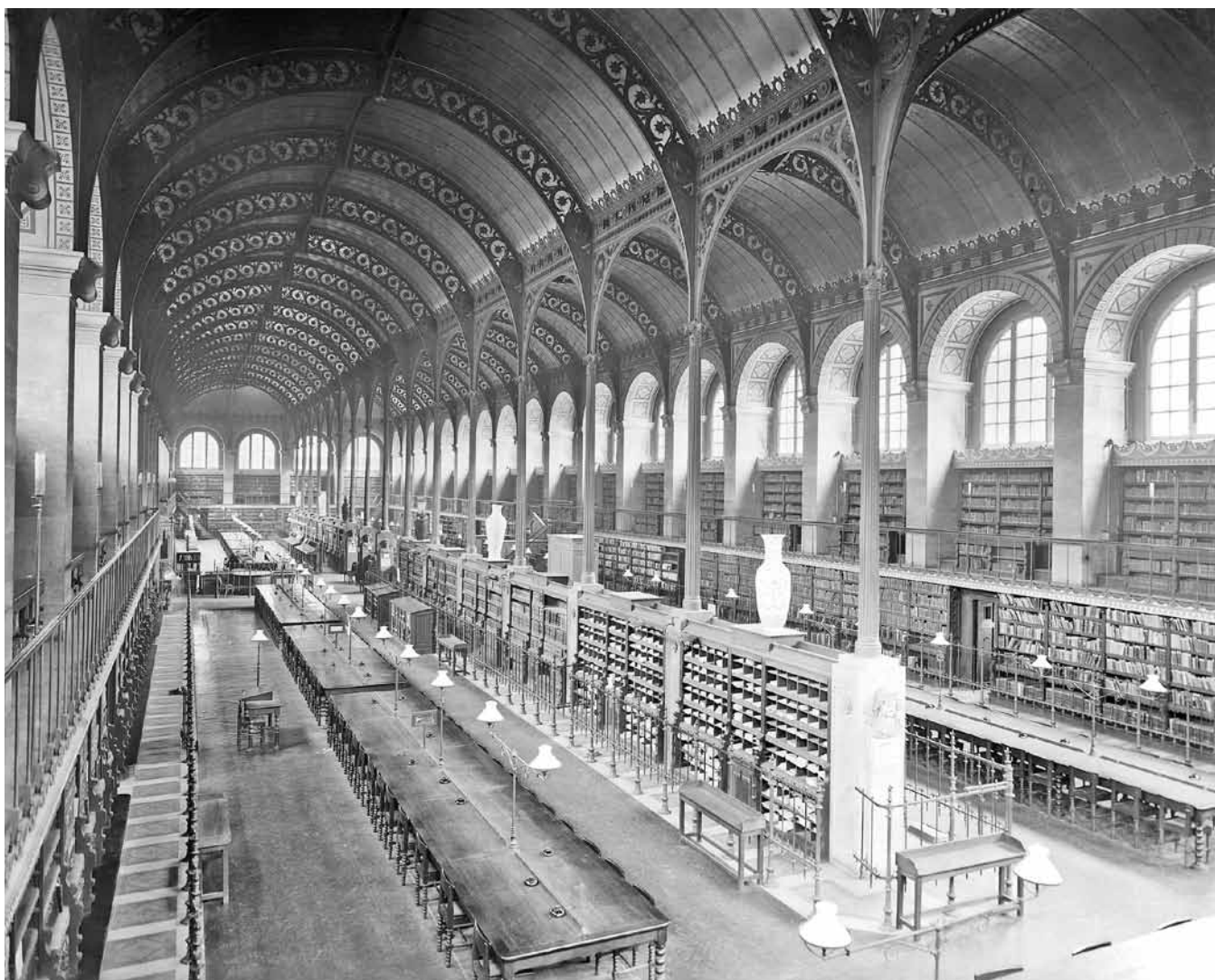
Figure 8. Auteur inconnu, Salle de lecture de la bibliothèque Sainte-Geneviève, début XX e siècle (© Roger Viollet/The Image Works). Vue depuis l'angle sud-ouest de la mezzanine.
