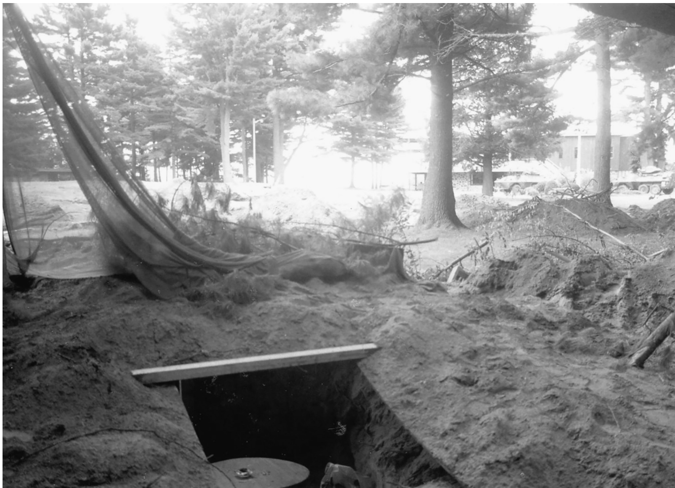
Tranchée creusée dans la pinède lors des événements de 1990 (Photo Pierre Trudel, 1990)
