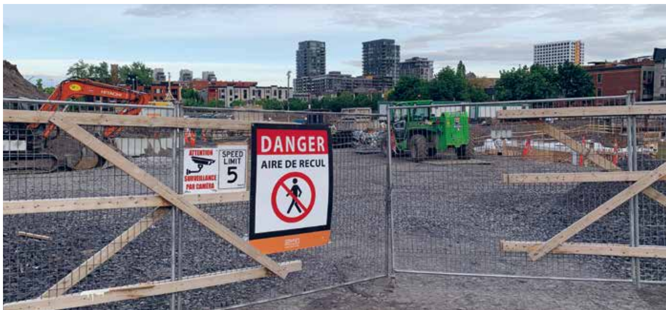
Le projet de condominiums Auguste & Louis en construction sur les anciens stationnements du site de Radio-Canada, coin Wolfe et René-Lévesque. Photo : Myriam Cloutier
