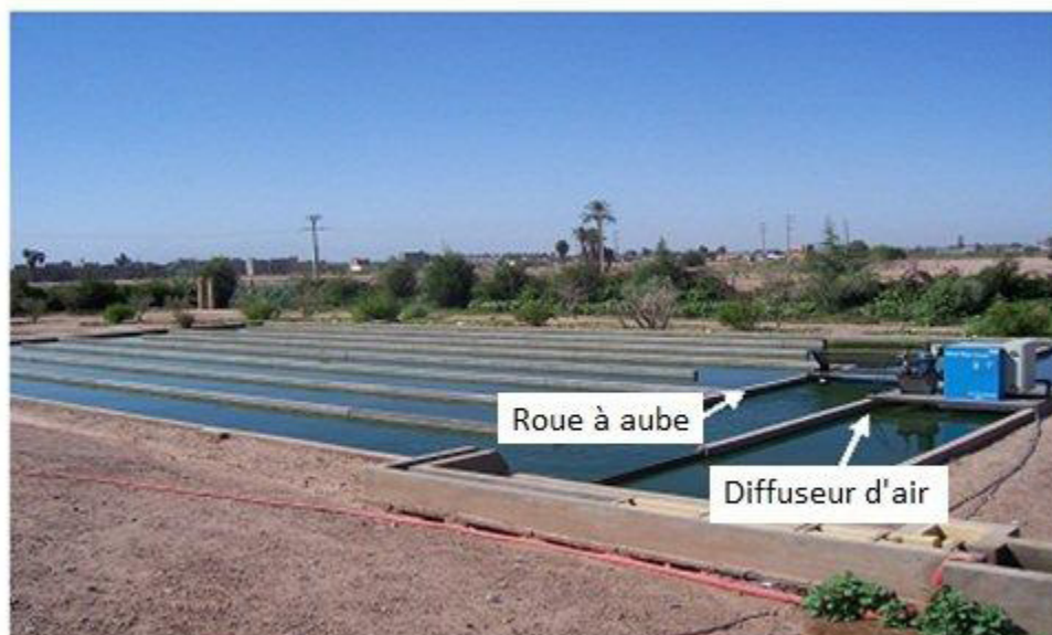
Figure 1. Plan du chenal algal à haut rendement de Saada (Marrakech, Maroc) avec les deux systèmes d'agitation utilisés (diffuseur d'air et roue à aube). Outline of the high-rate algal pond at Saada (Marrakech, Morocco) with the two aeration systems used (air lift and paddle wheel).
