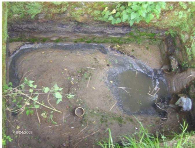
**Figure 10. Vue du colmatage des filtres par la formation d'une couche de boue.**
