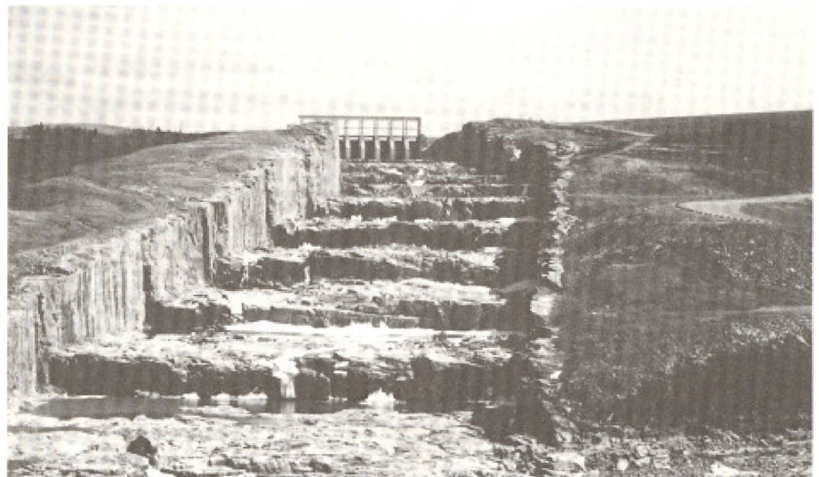
Pour qu'une ressource, si riche soit-elle en elle-même, devienne touristique, il faut la transformer en une attraction. Comment? Sur la photo, l'évacuateur de crues à LG-2. (Baie James)
