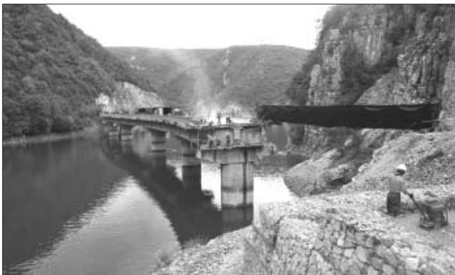
Reconstruction d'un pont par les troupes britanniques près de Sipovo (Bosnie Herzégovine). Photo : OTAN.
