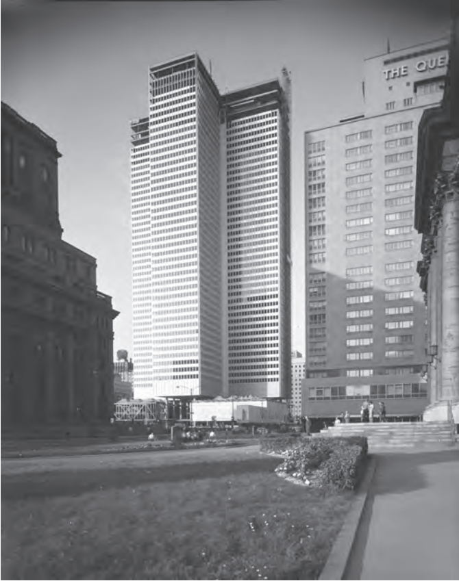
Figure 10: Place Ville-Marie under construction (Archives de Montréal).
