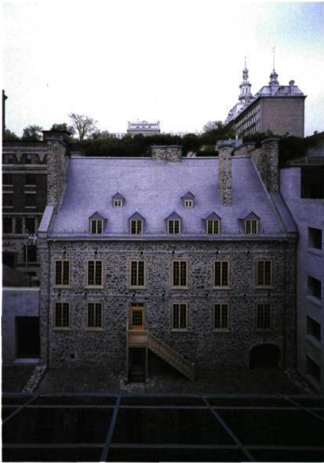
Bâtiment intégré à l'architecture du Musée: La Maison Estèbe construite en 1752 et la cour intérieure (Photo Pierre Soulard)
