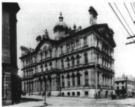
Édifice Dominion, 1880. Bureau de Poste d'Halifax. Nouvel édifice du Musée des beaux-arts. (Photo, Archives publiques de la Nouvelle-Écosse)
