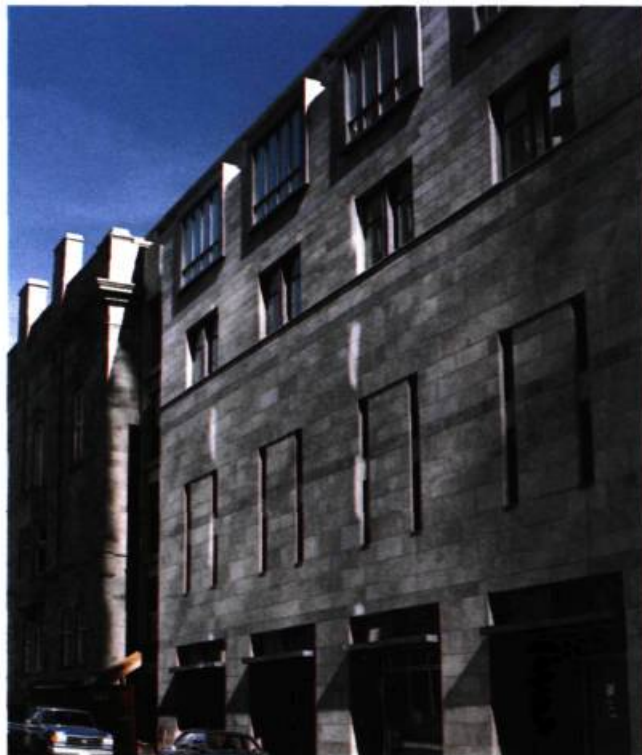
Musée McCord d'histoire canadienne. Façade du musée agrandi montrant la relation entre l'ancien et le nouveau bâtiment, photographie prise pendant la construction.
