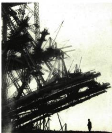
Chantier du pont de Forth (Écosse) photographié par Evelyn Carey Collection Centre canadien d'architecture
