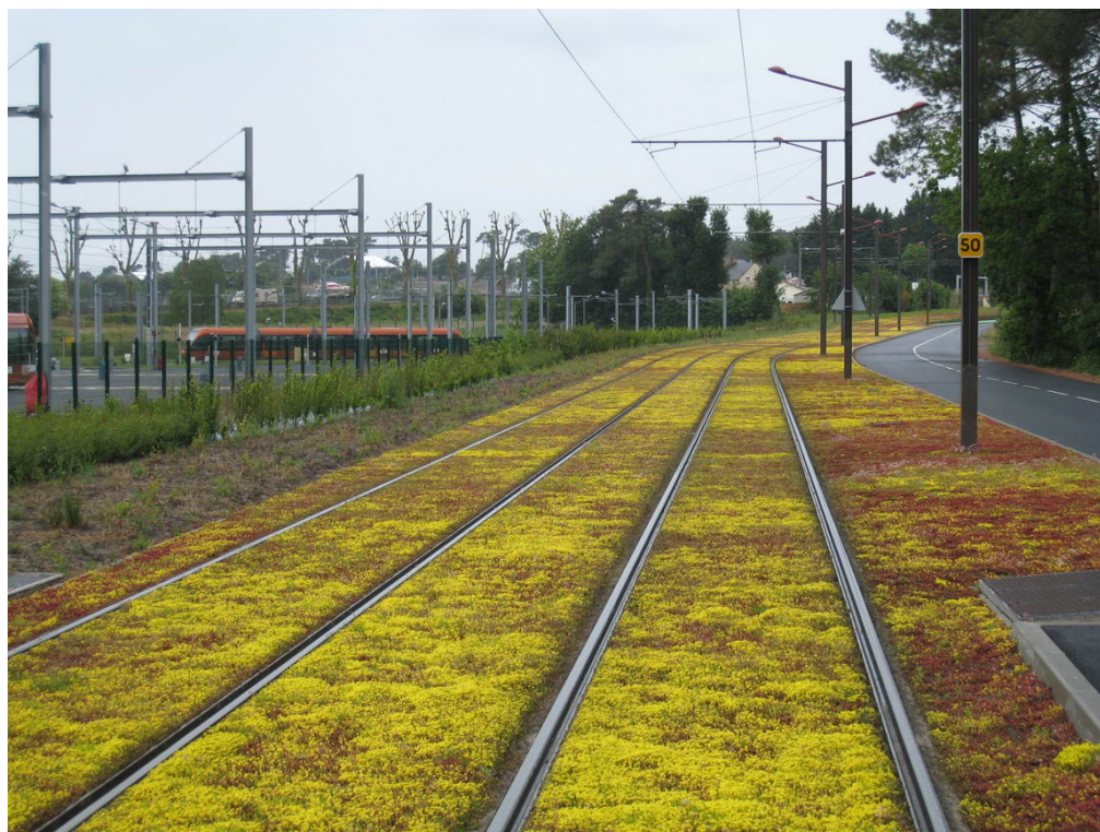
Figure 4. Verdissement des voies de tram à Montpellier : le sedum, plante grasse, près du dépôt Le Mans
