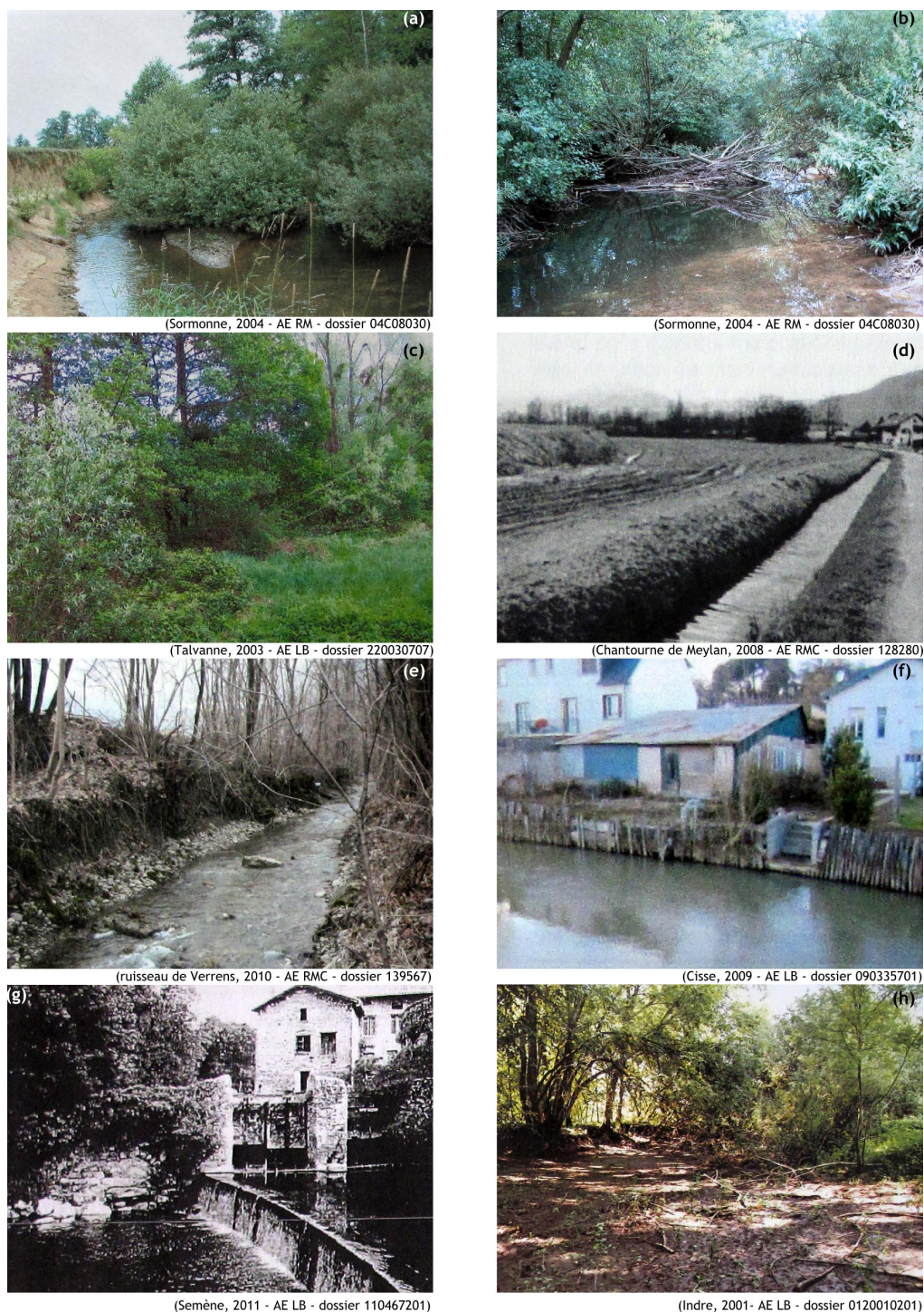
Figure 7 - Illustrations photographiques des dégradations déclarées dans les dossiers d'aides aux travaux de « restauration de cours d'eau » : développement de la végétation en lit mineur (a), problème d'écoulement (b), fermeture du milieu (c), dégradation générale des habitats aquatiques (d), problème morphologique (incision du chenal) (e), érosion ou instabilité des berges (f), problème de continuité (g) et dégradation des milieux annexes (h).
